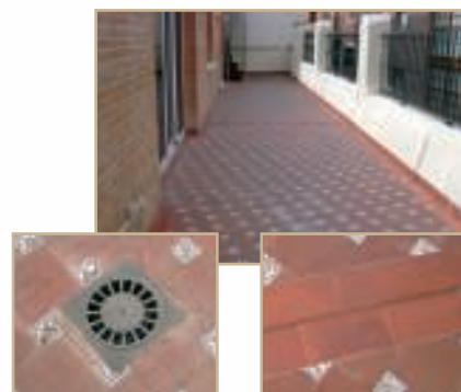
LOCALIZACIÓN CUBIERTA -Plana No Transitabile
