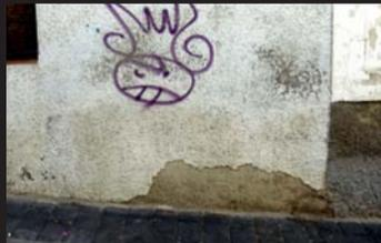
El desprendimiento de parte de la pintura puede ser debida a la baja adherencia del yeso debida a una inadecuada composición, que unido a factores climatológicos (viento y lluvia), provocan la erosión en esta zona debilitada.
