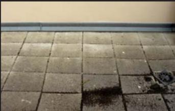
La suciedad observada en las fotos 42 y 43 se debe a un descuidado mantenimiento de las cubiertas, que requieren una revisión y limpieza periódicas. La acumulación de suciedad puede obstruir los sumideros y bajantes, y provocar inundaciones que den lugar a filtraciones de humedad a través del forjado de cubierta.
