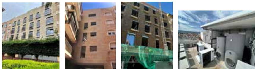
Se trata del primer edificio de viviendas con certificado PASSIVHAUS de la Región de Murcia. Este certificado supone el cumplimiento de los estándares de eficiencia energética superiores a los niveles que tiene que cumplir la construcción convencional. El diseño pasivo de las viviendas asegura confort térmico, calidad del aire interior y bajo consumo energético (con un ahorro en energía de calefacción y refrigeración de, al menos, el 75%).
